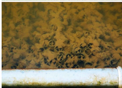
Obr. 1: Jednoduché zařízení na oxidaci a uložení vysráženého železa na přítoku do líhně
