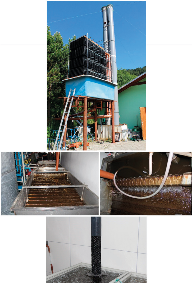
Obr. 2: Zařízení na odplynění přítokové vody (soustava biobloků, odplyňovací žlab na přítoku do líhně, nebo perforovaná vložka v přítoku do odchovného žlabu).
