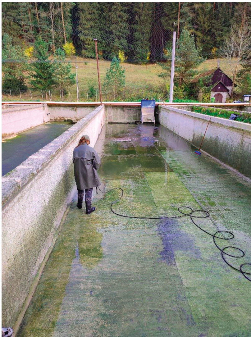
Obr. 9: Provádění sanitace odchovné nádrže
